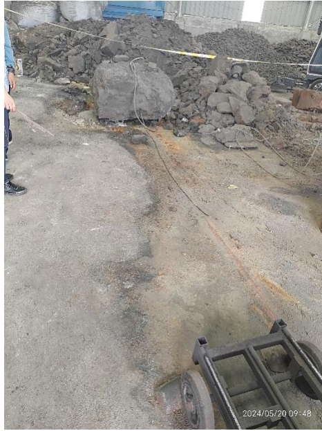
图 8 断裂的金刚石串珠绳（电动绳锯机万向轮下部）
