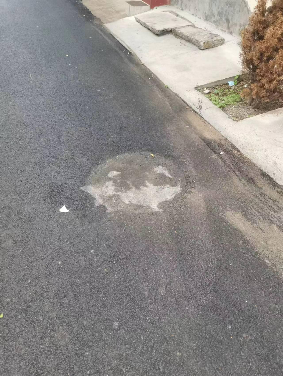
排水排污工程（检测口）
